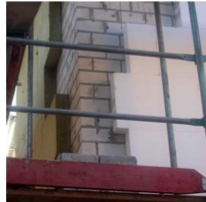
Wärmedämmung eines Gebäudes mit einem Wärmedämmverbundsystem - (c) Dipl.-Ing. Michael Schröder GmbH - Mülheim an der Ruhr
